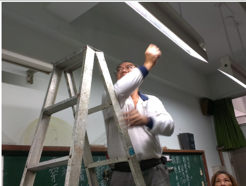
教室燈管定期維修
