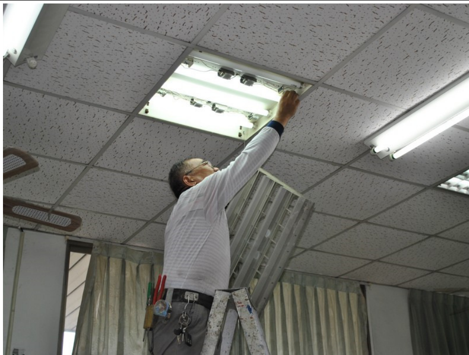
教室燈管定期維修
