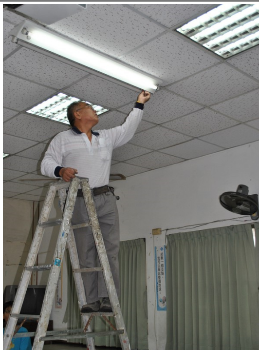
教室燈管定期維修
