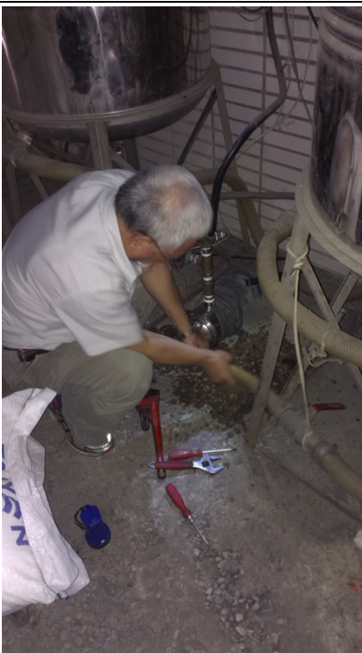
水塔定期檢修
