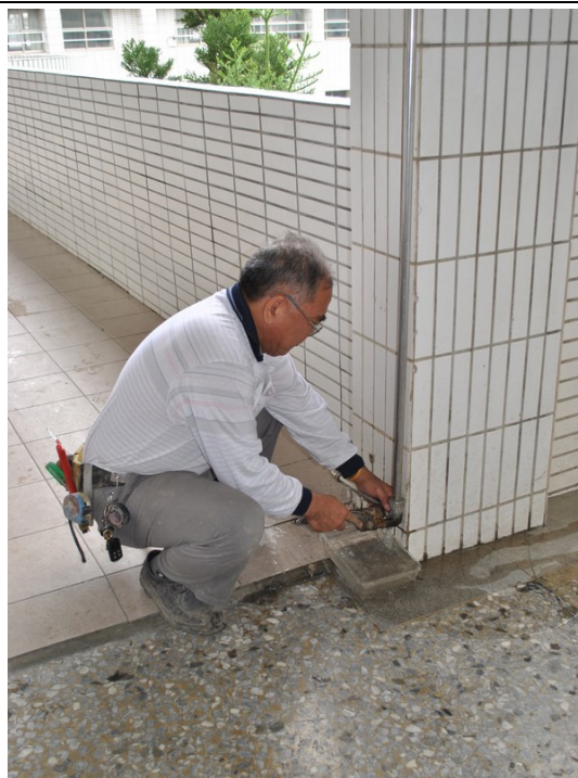
RO 水管維修
